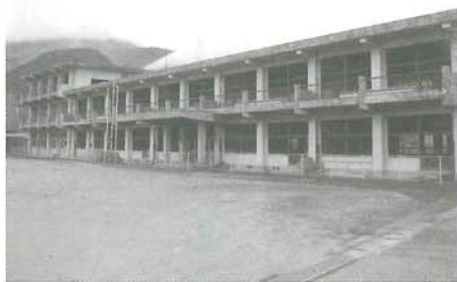
旧大野木場小学校（火砕流で焼失・現況保存）
