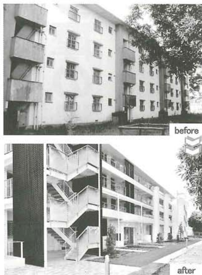
[写真2] A棟北東側から見る
