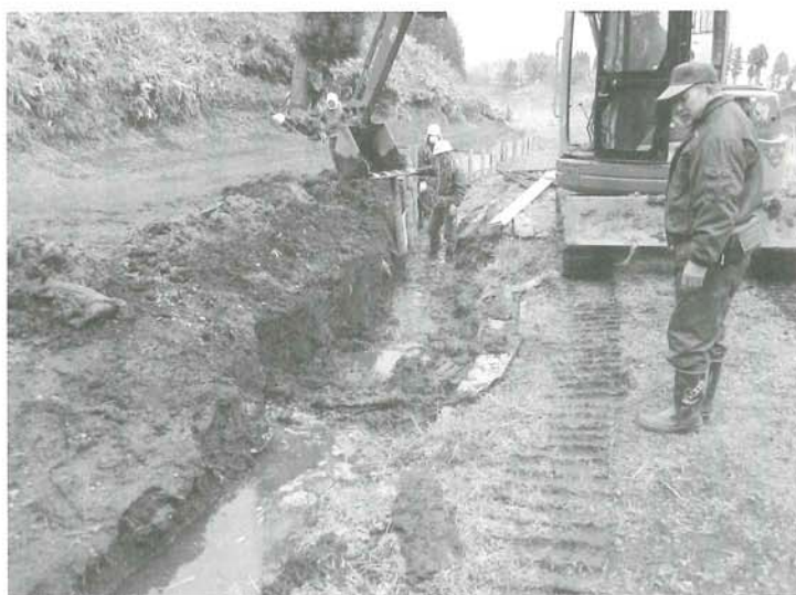
ホタルの生息に欠かせない水路の改修工事
