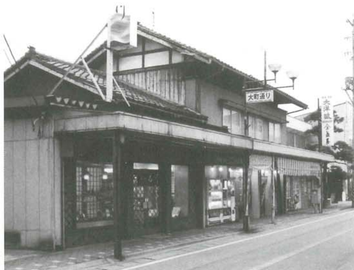
町屋の外観再生前
