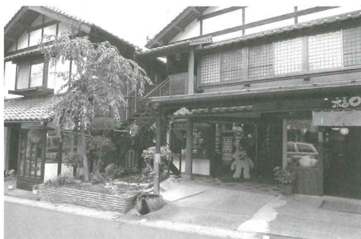
協議により看板を撤去した店舗
