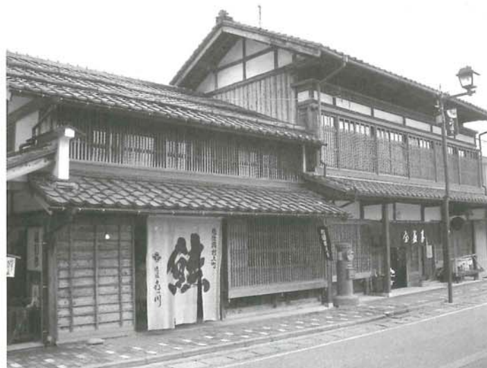
町屋の外観再生後
