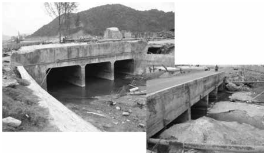
構造的損傷がないRC橋（東日本大震災）
