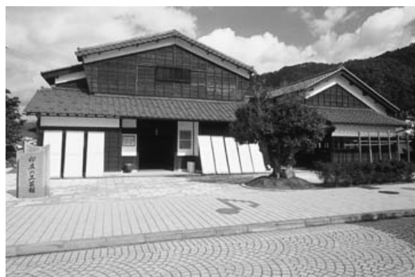
五箇地区の卯立建築
