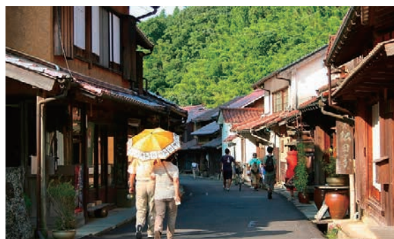
■大森町並み 電線の完全地中化によりすっきりとした町並みになりました。
