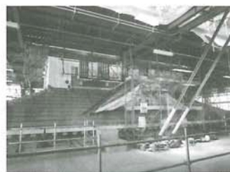
姫路城大天守の修復の様子 (姫路市)
