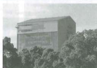
素屋根に覆われた大天守 (姫路市)
