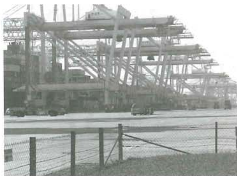
ロッテルダム港の荷役施設
