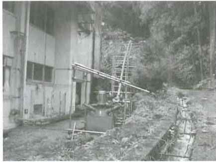
小水力発電実験施設
