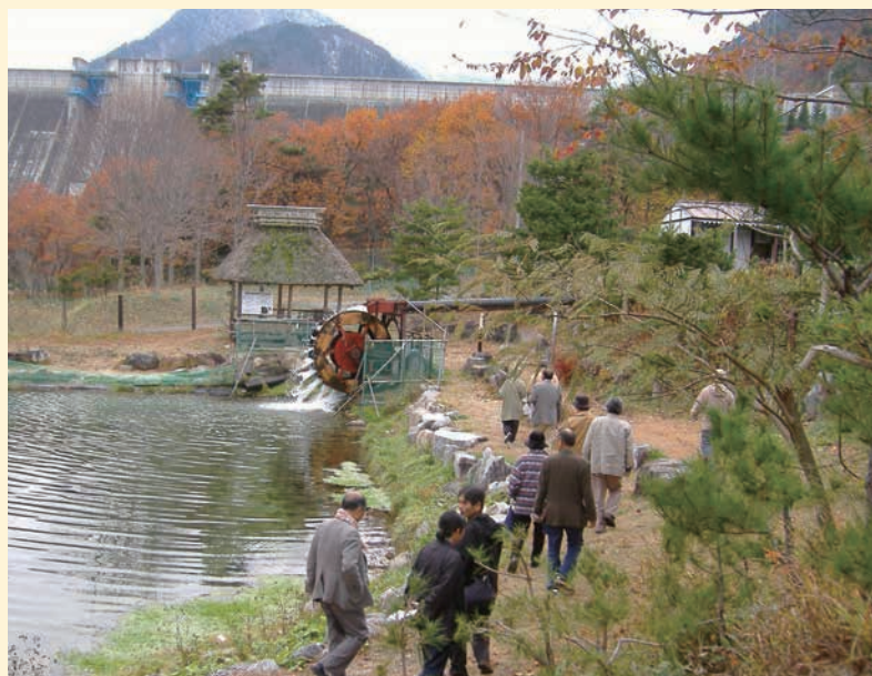
周辺環境に配慮したクラシック水車によるコラミ平ミニ水力発電 ● 長野県大町市 (p20-21)
