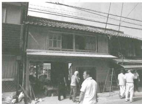
長屋の改築作業の様子
