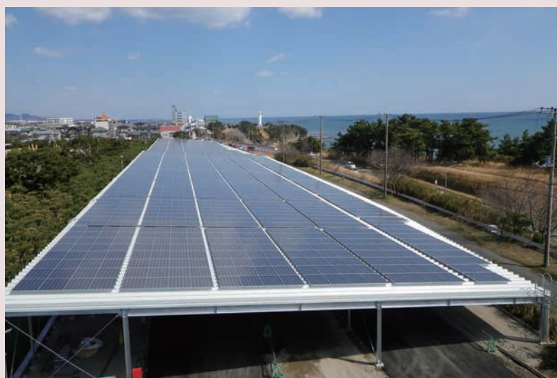
工場の駐車場に設置された太陽光パネル
