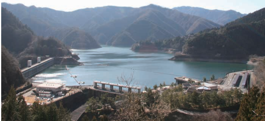
■町のシンボル奥多摩湖（東京都水道局小河内貯水池～小河内ダム）
