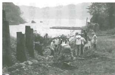
写真3 岩手県釜石市で水路の補修をするボランティアたち(船田浩二撮影)
