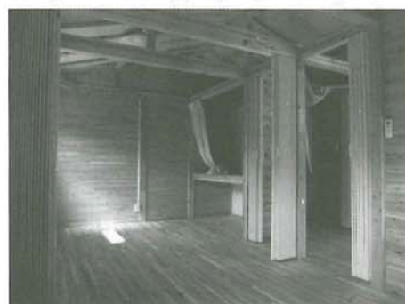
木造応急仮設住宅の内部
