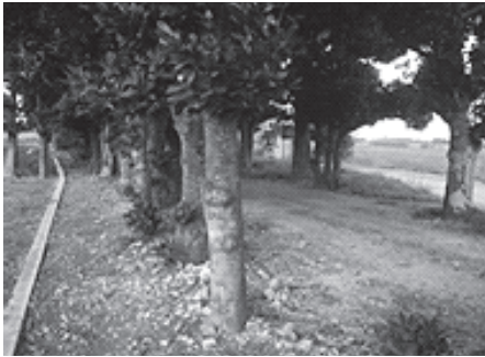
参道の南側に設置された鍬止め擁壁 平成22年度事業で進められた
