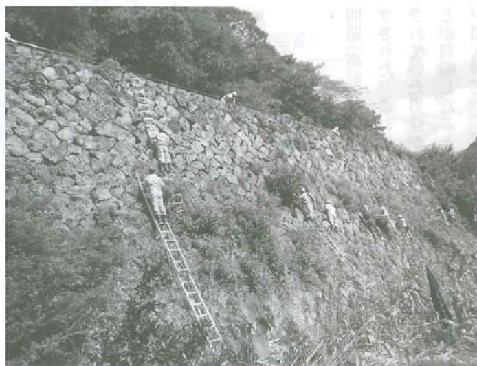
安政年間に築かれたという石垣を維持・保存する作業
