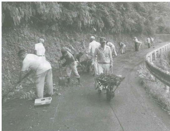
県道の清掃作業
