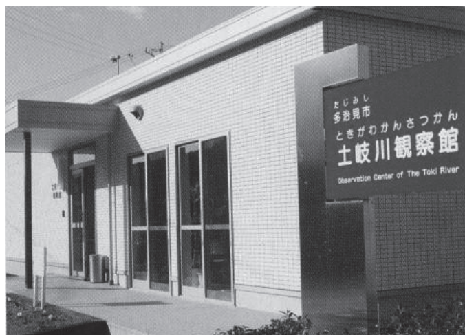
太陽光を反射するクールアイランドタイルを施行した建物
