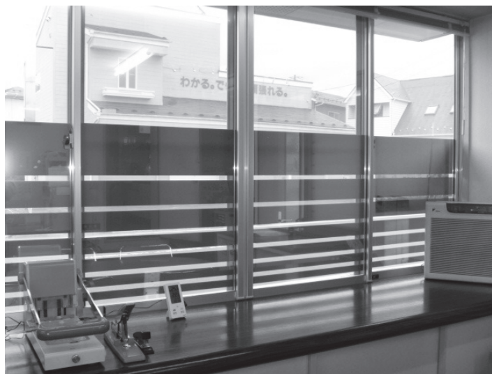
断熱シートを貼った窓（企業）
