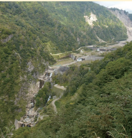
白岩堰堤砂防施設。砂防施設として初めて国の重要文化財に指定された
