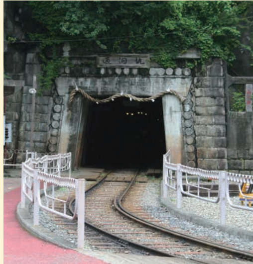
足尾銅山の主要な坑道の一つ「通洞坑」（国史跡）
