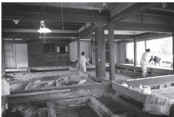
田楽庵の再生工事の様子
