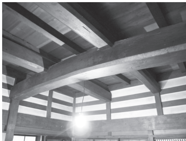
移築予定の古民家の内部。「杵の内」という特徴的な梁組構造を持っている
