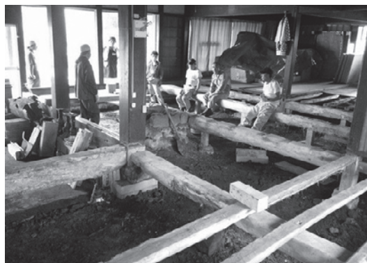
柱の修復作業が終わった古民家
