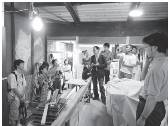
町会所の改修工事の現場見学会
