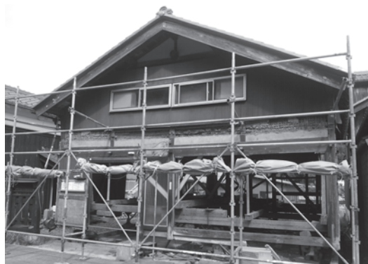
古民家の保存修理の様子
