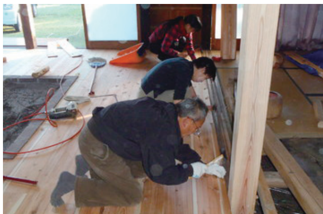
築100年の古民家の再生作業。丁寧に床板張りをする様子
