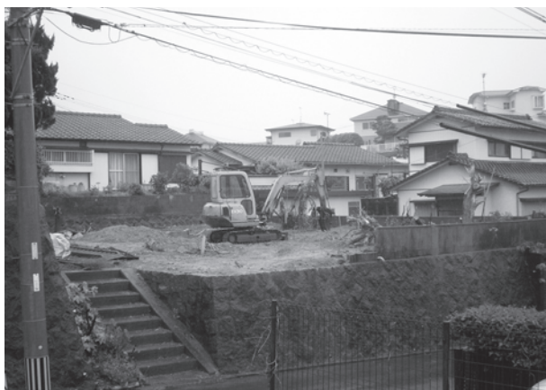
買受人により繁茂した雑木類と危険老朽家屋が撤去された
