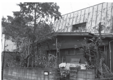
樹木が伐採され
