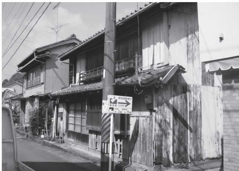
取り壊し予定の老朽空き家（中央）。前の道路と横の路地は避難路。 撮影者の背後100メートル余りに港がある
