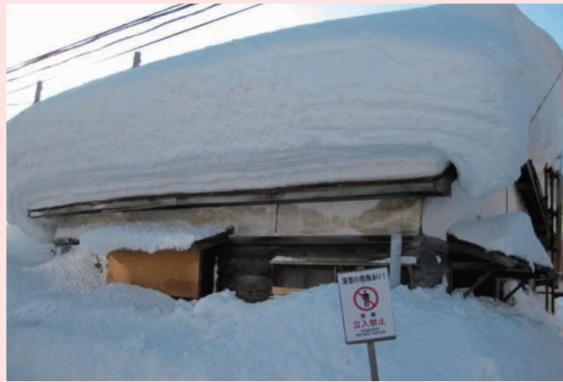
雪に埋もれた冬の後志の空き家
