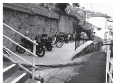
竣工後（地域の要望により駐輪場として整備）
