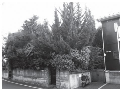
樹木に覆われた空き家
