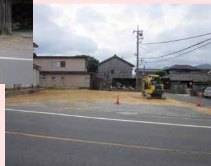
空き家が解体され更地に(指導後)
