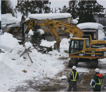
代執行による解体工事に着手した様子
