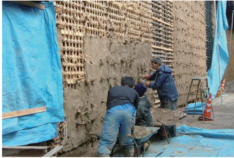
土蔵の再生。泥団子を塗り、土壁を造る作業を進める様子 ● 富山県富山市 (p16-17)
