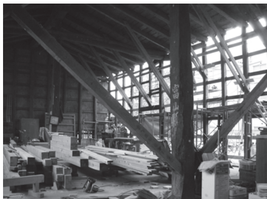
再生前の土蔵の内部
