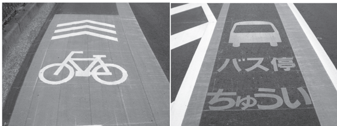
自転車レーンには、走行者に分かりやすい路面サインが施されている
