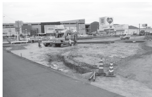
新駅の建設工事の様子
