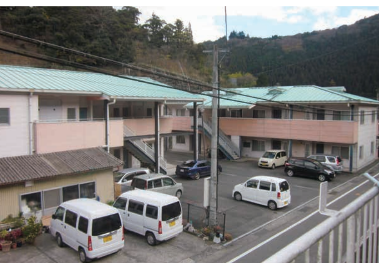
西米良村が若者の定住促進に向け建設した独身者専用住宅。2棟、全部で16戸ある ● 宮崎県西米良村 (p30-31)
