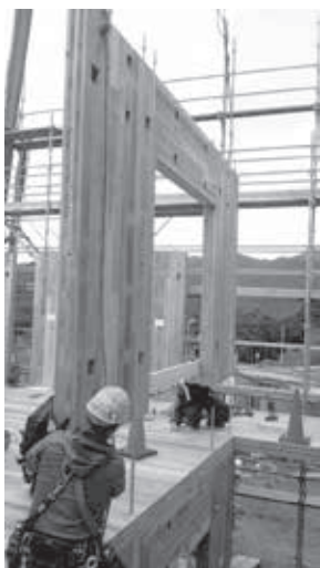
新建材 CLT を構造材として使用した、国内初の建物「高知おおとよ製材社員寮」の建設の様子。特別な認定を得て、実験的に建てられた
