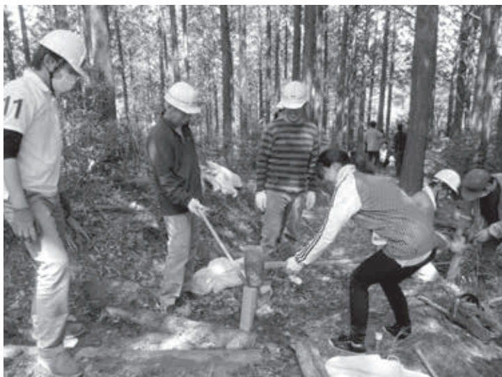
企業関係者による熊野古道の補修作業
