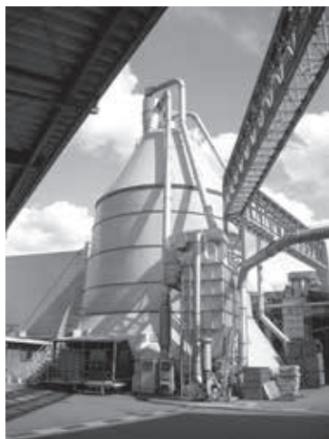
発電用のサイロ（かんな屑の保管庫）。2000立方メートルの容量だが、かんな屑を利用せず溜め続けると、3日ほどで満杯になってしまふ
