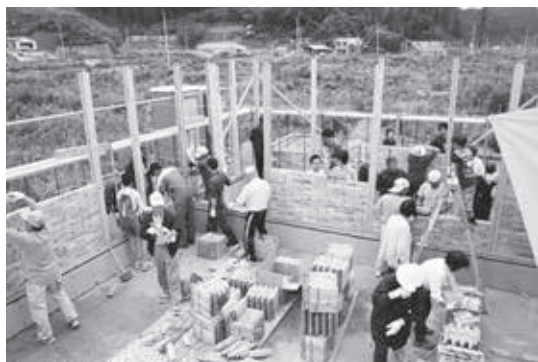
(上) 木材パーツを重ね、 集会所を造る様子 (左) キットで組み立てた スツール
