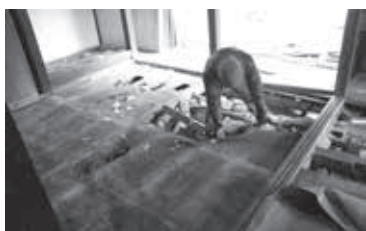
古民家再生。腐った床下部分の撤去作業
