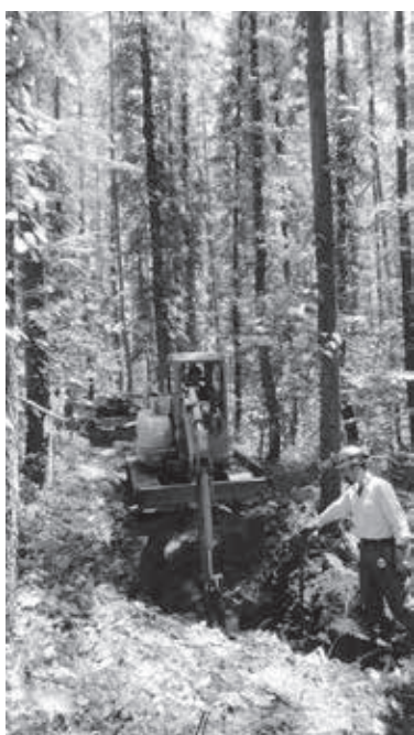
森の中の作業路網整備。重機を使い、幅3.5メートル程度の道を整備する様子
