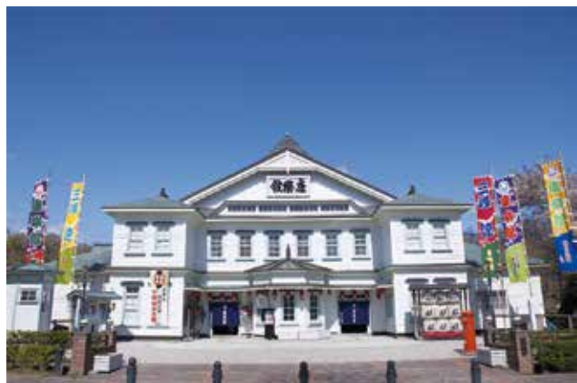
明治43年建築の芝居小屋「康楽館」。今では貴重な観光スポットになっている
