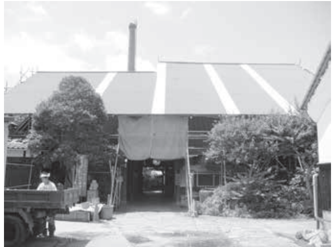
素屋根をかけて本格的な土蔵修理が行われている伝建地区内の修理工事の様子
