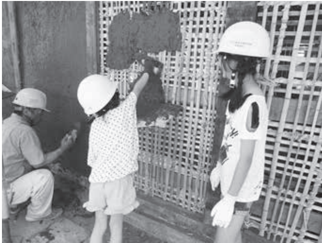
国立小山高専と共催した土壁塗りワークショップの様子。土壁塗り（荒壁打ち）に子どもたちもチャレンジ
