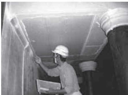
改修工事の様子
