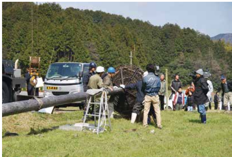
コウノトリの巣塔の設置工事
