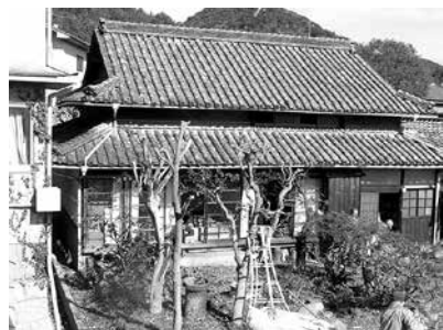
整備後の交流拠点：屋根を修復し、屋内、屋外ともに整備しました
