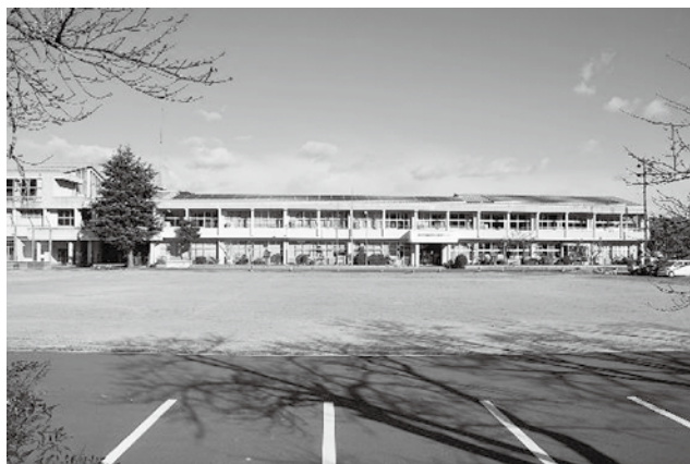
屋根に太陽光発電を設置した旧与布土小学校校舎
