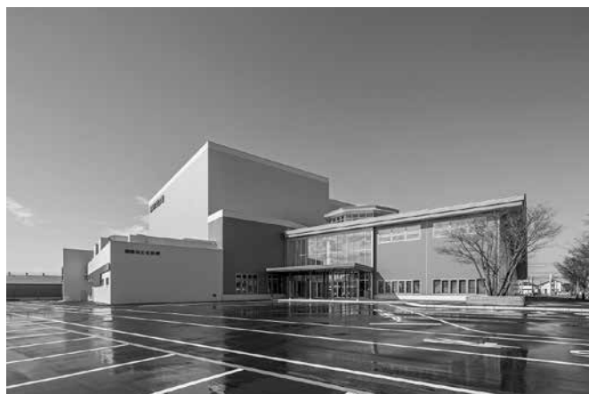
文化会館外観（手前：低層部ラウンジ棟、奥：高層部ホール棟、後方：設備棟）
