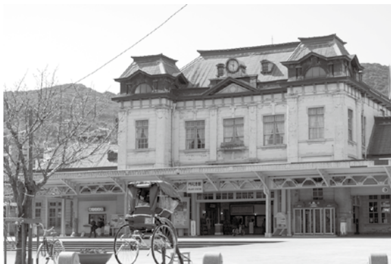
JR 門司港駅。現在は平成 30 年 3 月まで大規模保存修理工事中
