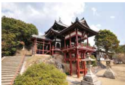
■西方寺普明閣 市重要文化財の竹原市の景観の中心となる重要な建築
