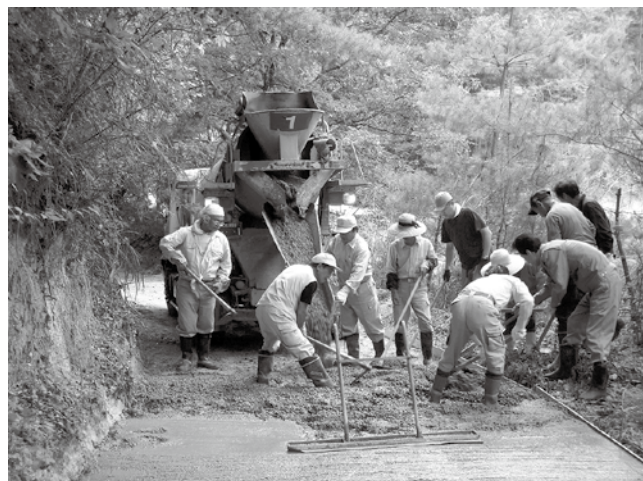
材料支給事業。住民自らによる林道整備
