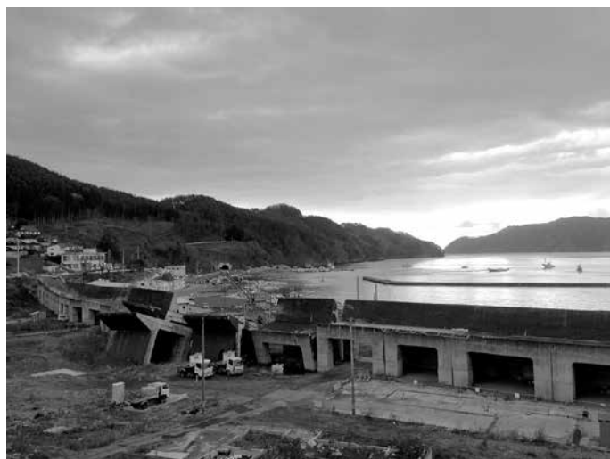
釜石の東日本大震災後の風景
