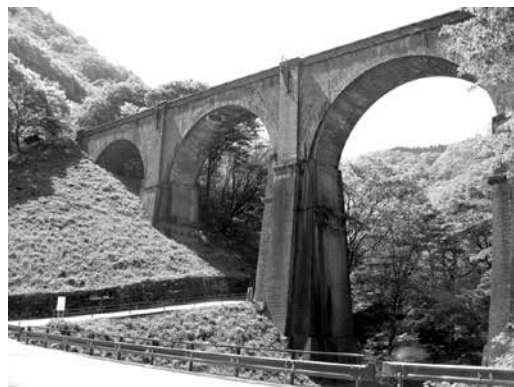
碓氷第3橋梁：通称めがね橋
