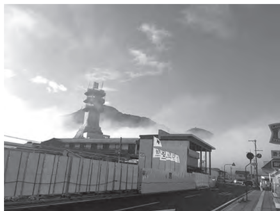
開発工事の進む、JR備中高梁駅前
