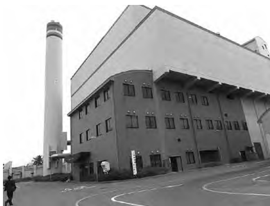
ベース電源であるごみ発電（米子市クリーンセンター）
