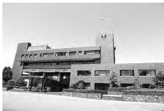
電力供給している公共施設例（米子市役所本庁舎）
