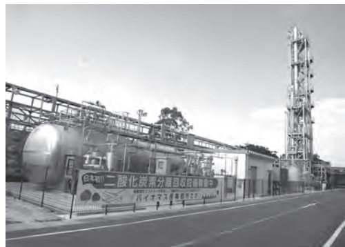
二酸化炭素分離回収設備
