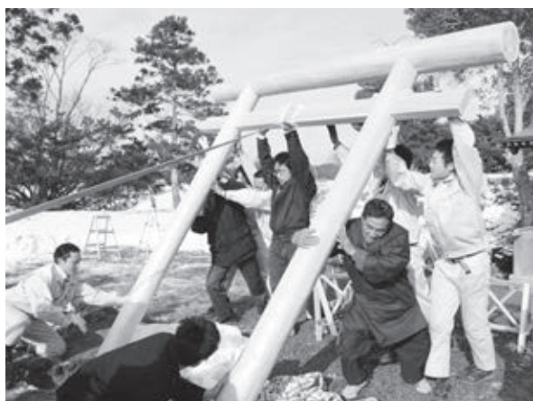
福島県山田神社にて鳥居設置
