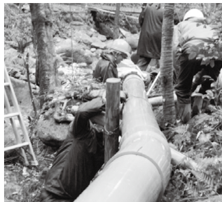
小水力発電導水管 集落住民による工事
