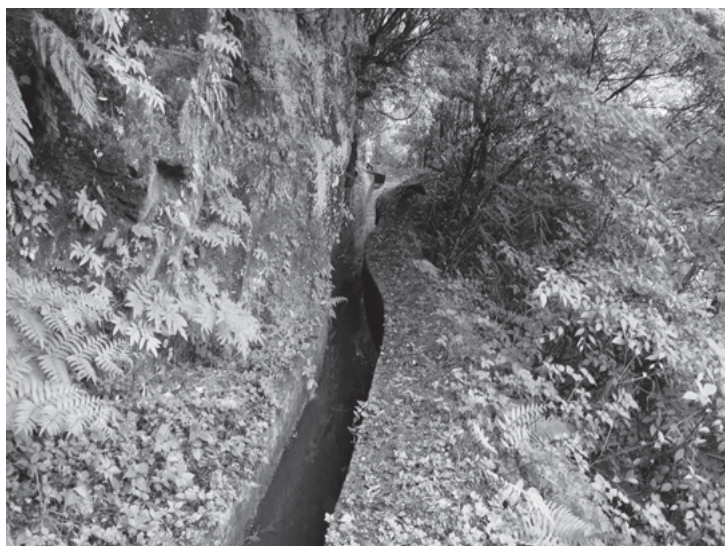
高千穂郷・椎葉山地域の棚田に水を導く総延長 500 キロにも及ぶ山腹水路
