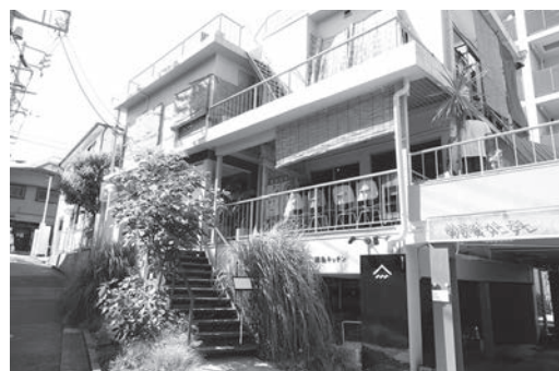
離島キッチンの外観
