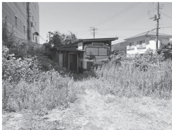
空き施設であった島原集会所の全景
