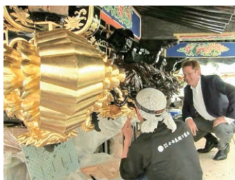
文化財修復現場の様子
