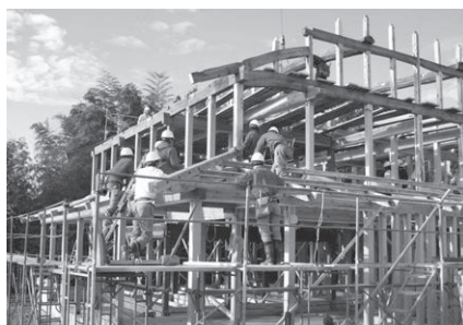
開ヶ丘キャンパス「交流館」（古民家再生）建方実習（富山市）
