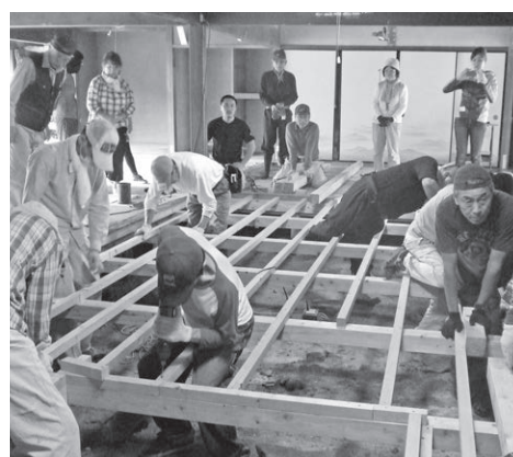
古民家リフォーム塾 床下の改修
