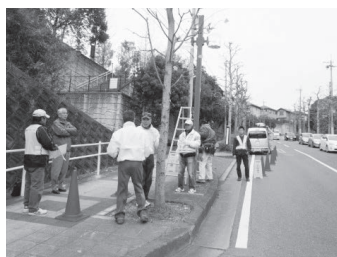
鹿ノ台街区内で防犯カメラの設置作業
