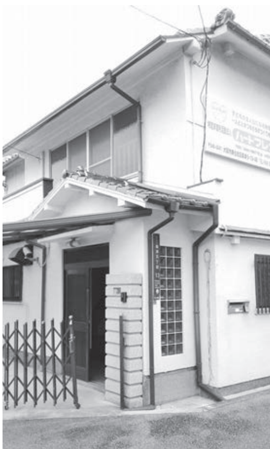
ハートフレンドの外観
