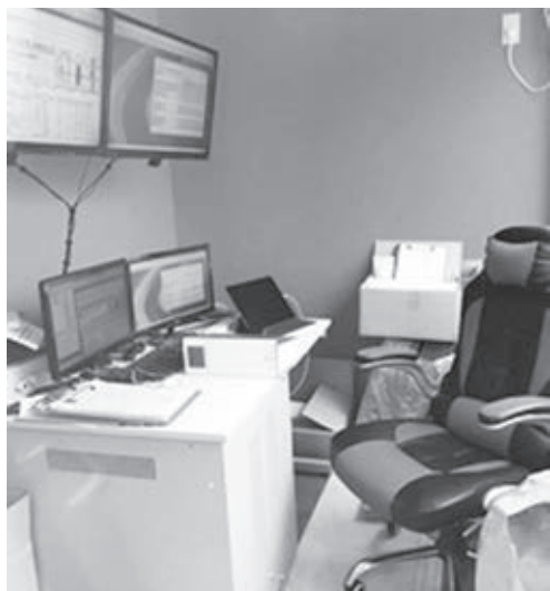
ハウス内の日射量等を管理するコンピューター室
