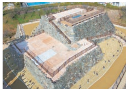
■郡山城天守台展望施設
