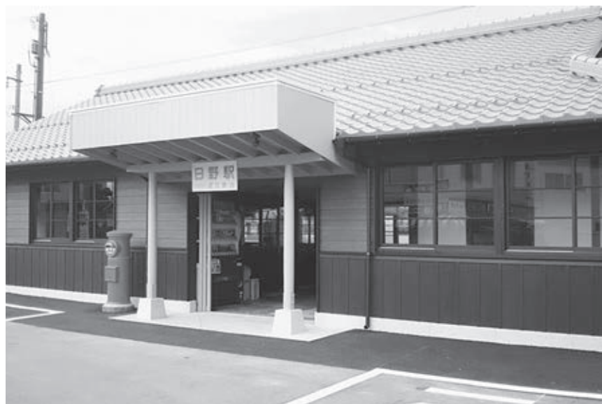
改修後の日野駅舎
