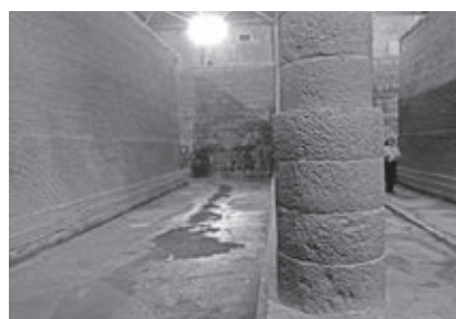
鎮守府4都市には優れた水道施設が建設された。写真は旧北吸浄水場第1配水池（舞鶴旧鎮守府水道施設）
