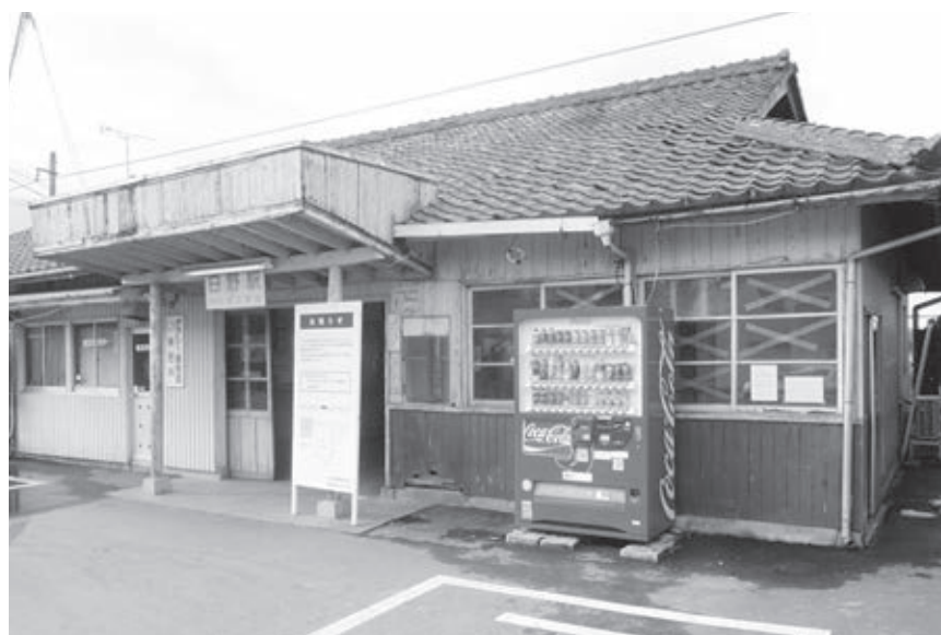
改修前の旧日野駅舎
