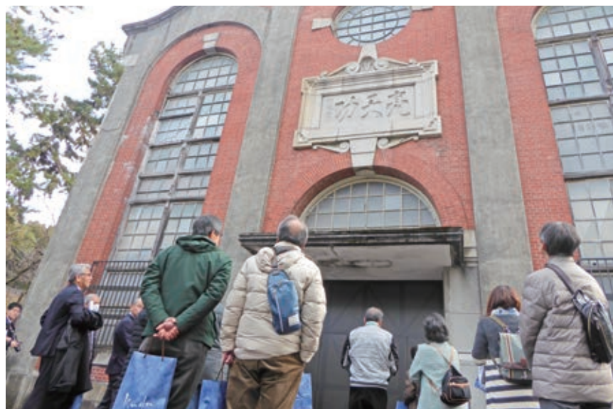
蹴上発電所特別見学会の様子
