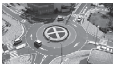
名古屋大学・国際交通安全学会と連携した社会実験と新たな交差点の整備。信号機を撤去しラウンドアバウトを整備した全国初の事例
