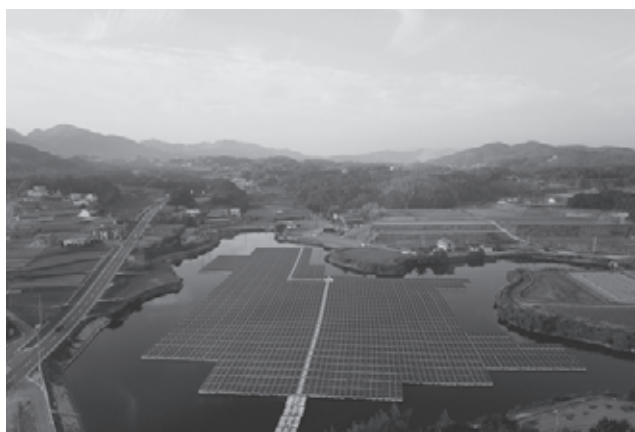
売電利益を地域に還元するため池ソーラー発電所
