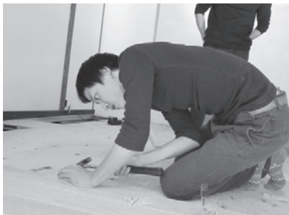
域学連携拠点改修の様子
