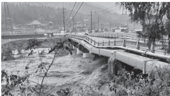
台風19号で被害を受けた山梨県大月市の様子
