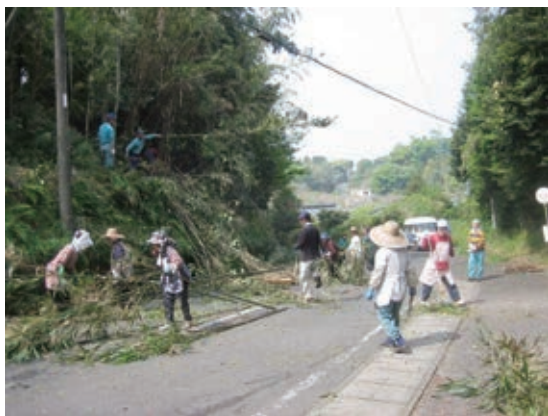
環境整備作業
