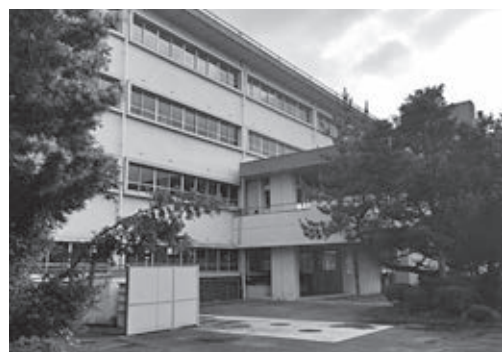
廃校を活用した「くらて学園」の全景
