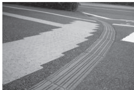
「UDブロック」ブロックに溝をつけることで車道と歩道を区別。点字ブロックとセットで設置
