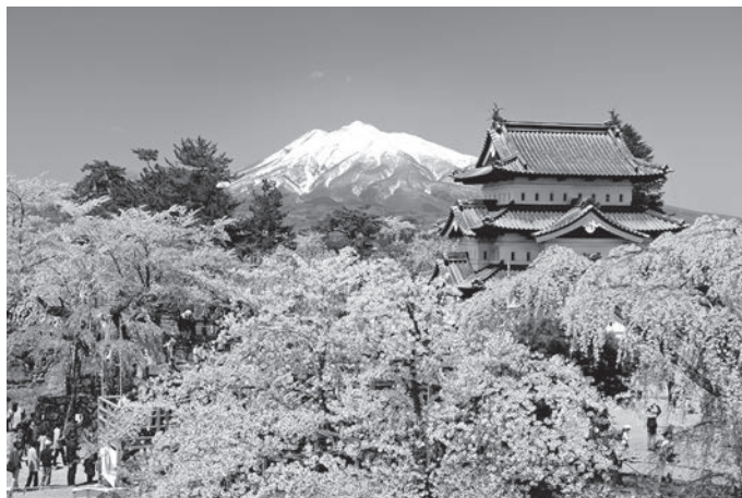
お城と桜と岩木山（天守曳屋後の写真）
