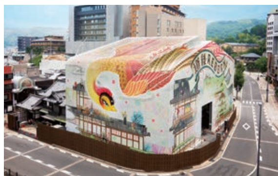
松山市 修繕中の道後温泉本館を覆う素屋根
