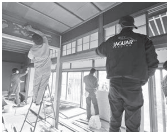
こたけ創造舎改修作業を行うボランティア
