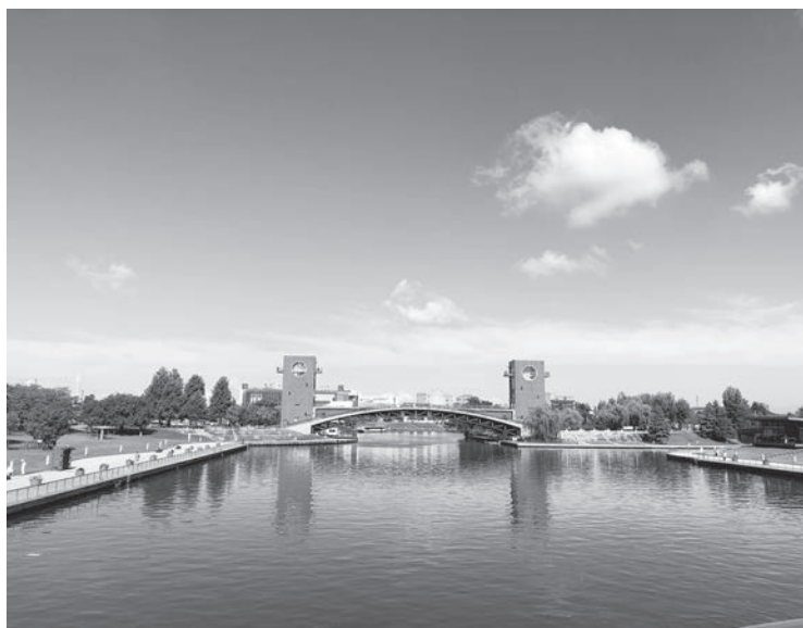
富山市総合体育館に隣接する富岩運河環水公園
