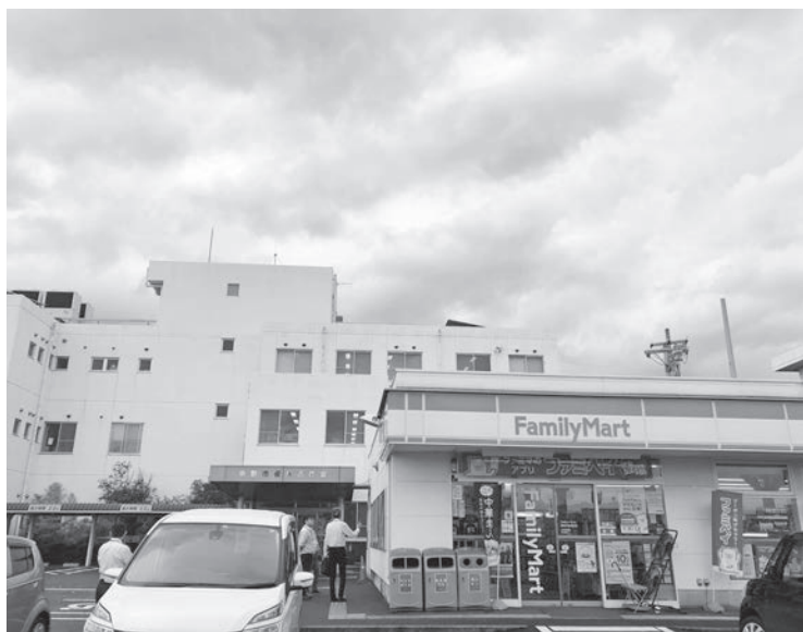
庁舎敷地内出店のコンビニ（秦野市）
