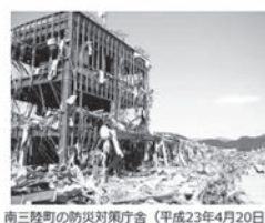
南三陸町の防災対策庁舎（平成23年4月20日）
