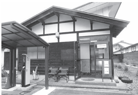
Semboku Complex 外観
