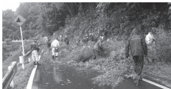
地域内の市道脇の竹やぶ伐採作業
