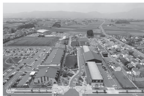
オガールエリアの全景
