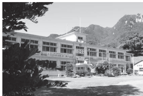
廃校になった小学校を工場にリノベーション
